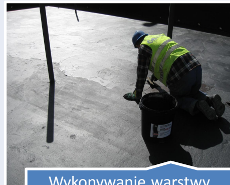
Wykonywanie warstwy paroizolacyjnej (taras, stropodach)
