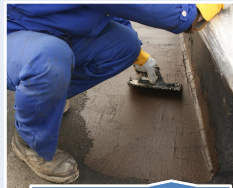
Mostkowanie rys
